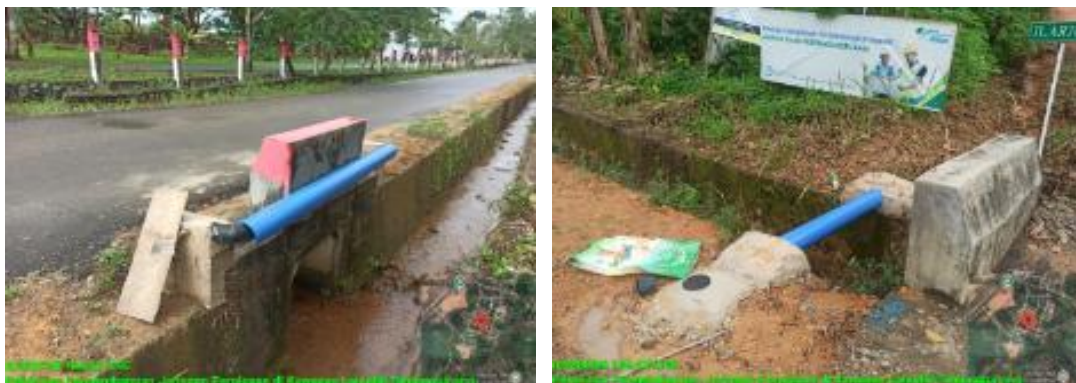
Gambar 3.17 Pengembangan jaringan perpipaan di kawasan LANUDAL Tanjungpinang
