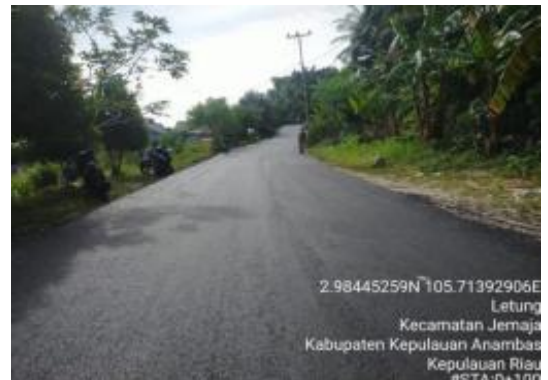
Gambar 3.4 Pemeliharaan Rutin Jalan Provinsi di Kabupaten Kepulauan Anambas
