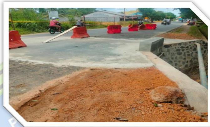
Gambar 3.6 Dokumentasi Peningkatan Jalan Nusantara Kabupaten Bintan
