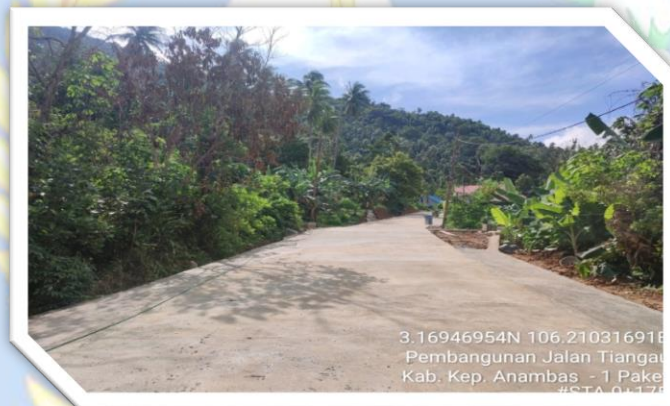
Gambar 3.7 Dokumentasi Pembangunan Jalan Tiangau, Kab Kepulauan Anambas
