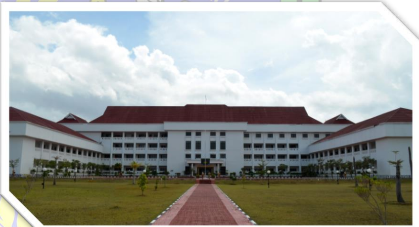
Keterangan: Kantor Pemerintahan Provinsi Kepulauan Riau
