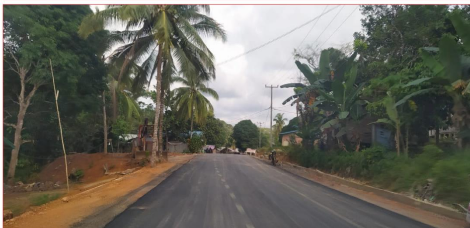
Gambar. 3.7 Peningkatan Jalan Sp Kerandin – Belungkur Kab Lingga (Lanjutan)
