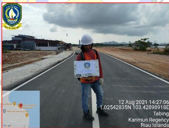
Gambar.3.5 Peningkatan Jalan Pesisir Pantai Karimun
