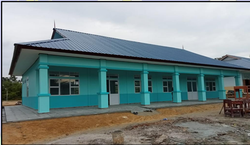
PEMBANGUNAN RUANG GURU, SMAN I BURU, KARIMUN
