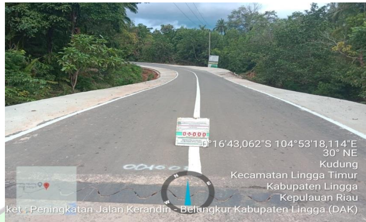
Gambar 3.13 Dokumentasi Peningkatan Jalan Kerandin – Belungkur Kabupaten Lingga (DAK)
