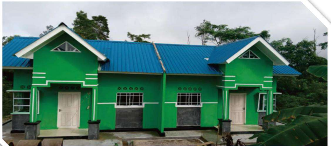
Pembangunan Rumah Dinas Guru Beserta Perabotnya (DAK) SMAN 1 SMAN 1 BUNGURAN TENGAH TAHUN 2022 DINAS PENDIDIKAN PROVINSI KEPULAUAN RIAU
