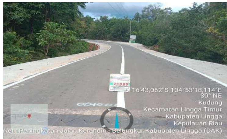
Gambar II.7 Dokumentasi Peningkatan Jalan Kerandin – Belungkur Kabupaten Lingga (DAK)
