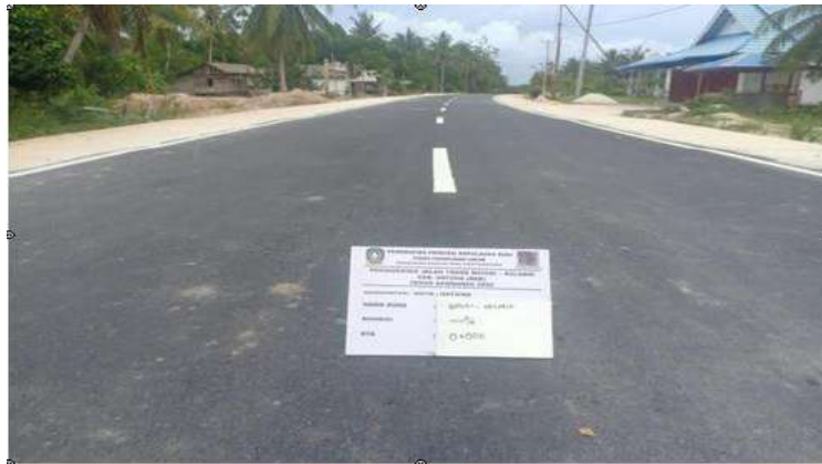
Gambar II. 6 Dokumentasi Peningkatan Jalan Trans Batubi – Kelarik, Natuna (DAK)
